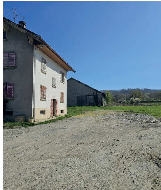
Le secteur de la future gendarmerie aujourd'hui : une ancienne habitation, un ancien corps de ferme, et un sol en friche
