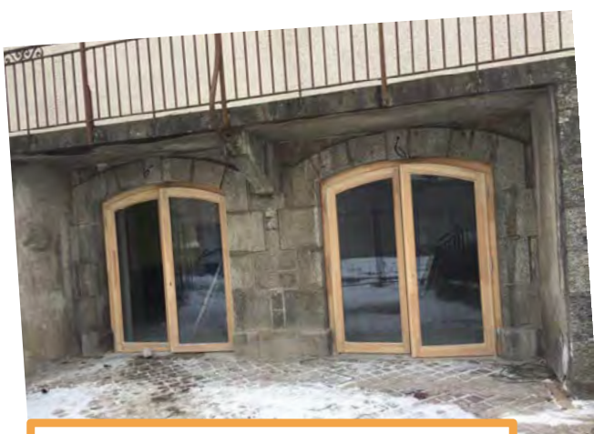
Ancienne chaufferie - Salle des pompiers
