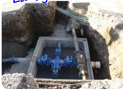
Un chantier sous la pluie ! Le changement de la colonne d'eau se poursuit, deux grosses chambres de raccordement ont été posées, une au croisement RD/Chemin de Becu, l'autre un peu avant le panneau de l'entrée de Faramaz. Entre la pluie, la boue, la complexité des réseaux toujours présente les ouvriers sont devenus de vraies «stars». Sans perdre le moral, ils espèrent quand même un temps plus sec pour ne pas avoir trop de décalage sur l'avancement des travaux.
