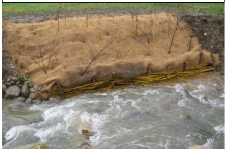
Vu de face du tressage terminé : géotextile plaqué sur la berge et boutures mises en place
